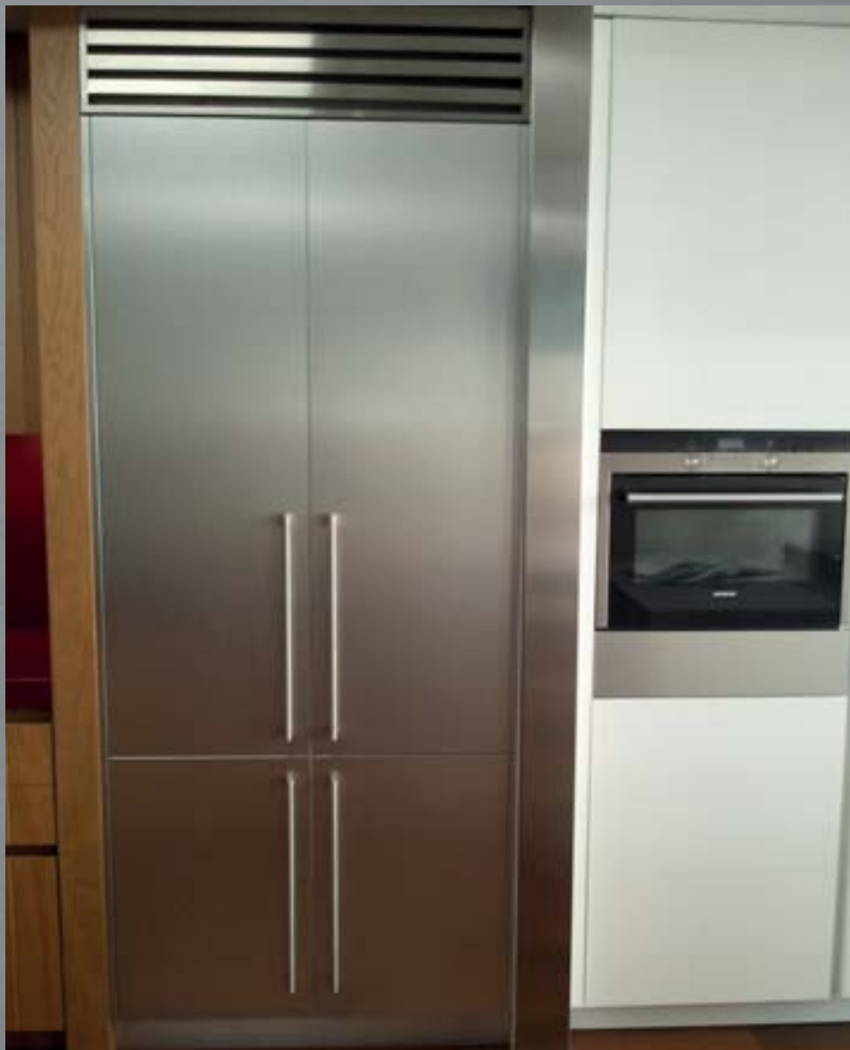
Instalación rejilla de ventilación
